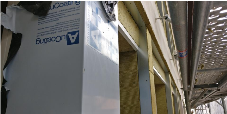
Isolation thermique des façades par l'extérieur
