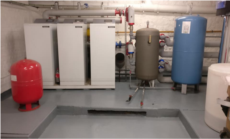
Rénovation de la chaufferie
