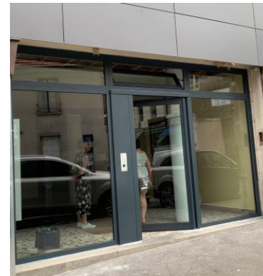
Remplacement des menuiseries privatives et collectives
