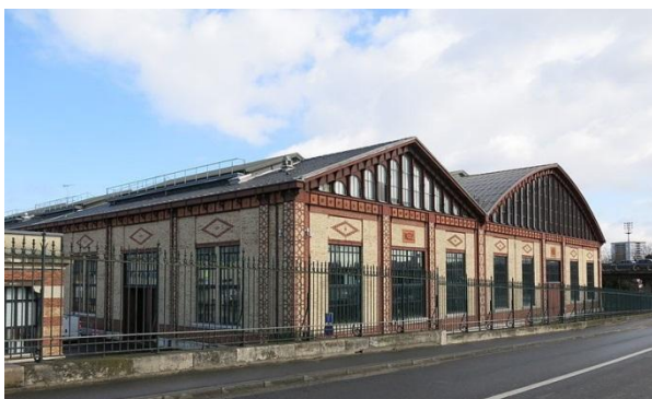
Usine élévatrice des eaux – Colombes
